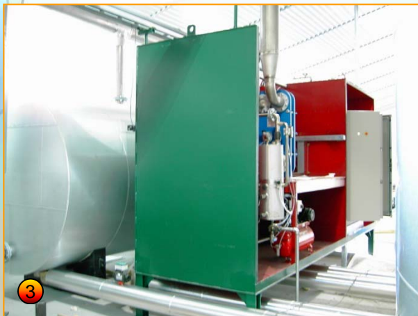
3-5: Kompakt platform til bestykning med pumpe- og ventilenhed - inklusive elskabet
